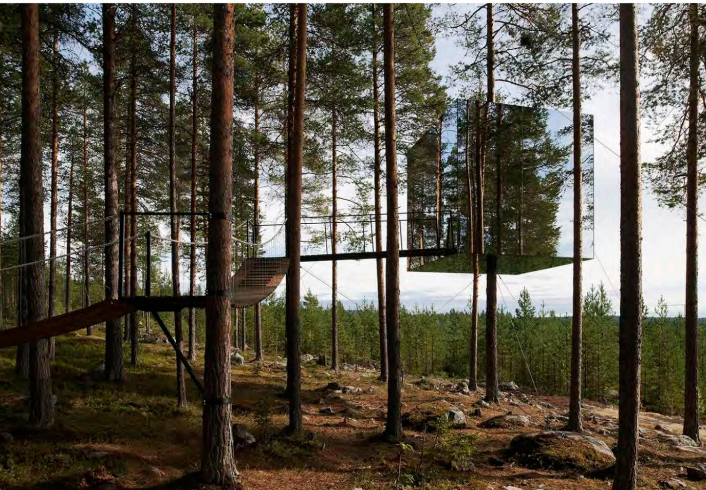
Модуль окружен зеркальными стенами, которые одновременно отражают окружающую среду и гармонируют с ней. Ствол дерева прорастает через комнату и заключен в алюминиевый каркас, который составляет основу комнаты. Еще одна интересная деталь, скрытая за зеркальным фасадом – балкон, позволяющий незаметно выйти за пределы дома.
