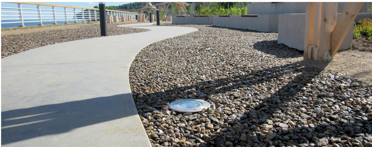
Пример композитного покрытия, Ultimax Gravity
