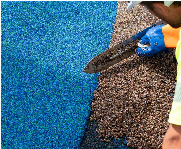
Пример наливного резинового покрытия
